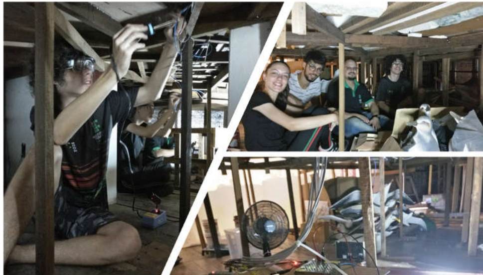
Figura 3: montagem e instalação da parte elétrica, fios e conexões.
